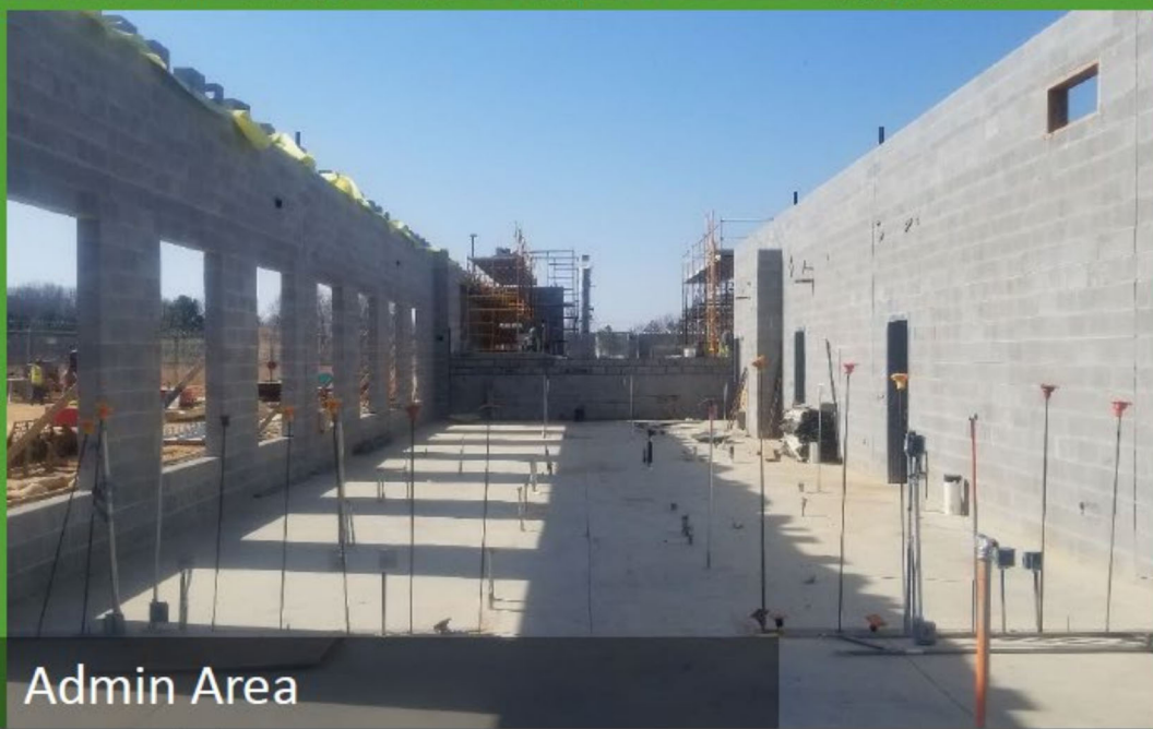
Last Slab on grade Concrete Pour
